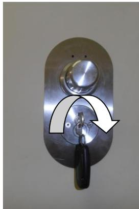
4. Zum Öffnen der Tür muss zuerst mit dem Schlüssel der Profilhalbzylinder in die „Offen“-Position zurückgedreht werden. Anschließend lässt sich der Fallenriegel durch Betätigen des Drehknafes wieder zurückziehen und die Tür wird freigegeben.
