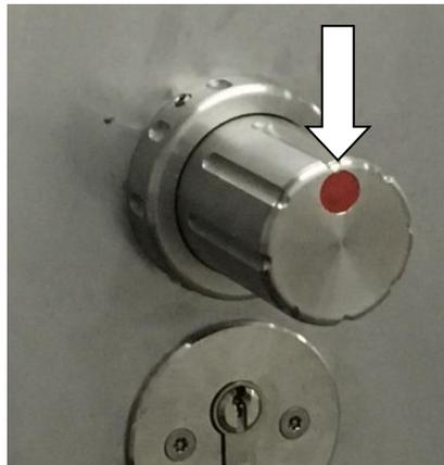
2. Zum Öffnen der Tür wird der Fallenriegel über den Drehknopf zurückgezogen und die Tür kann bewegt werden.
